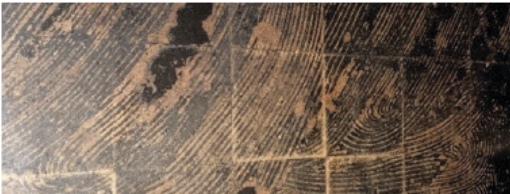
Асбестовый битумный клей, используемый для приклеивания напольной плитки
