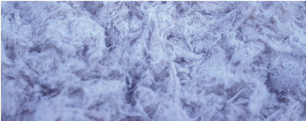
Lahtine sinine asbest seinaõõnsusest
